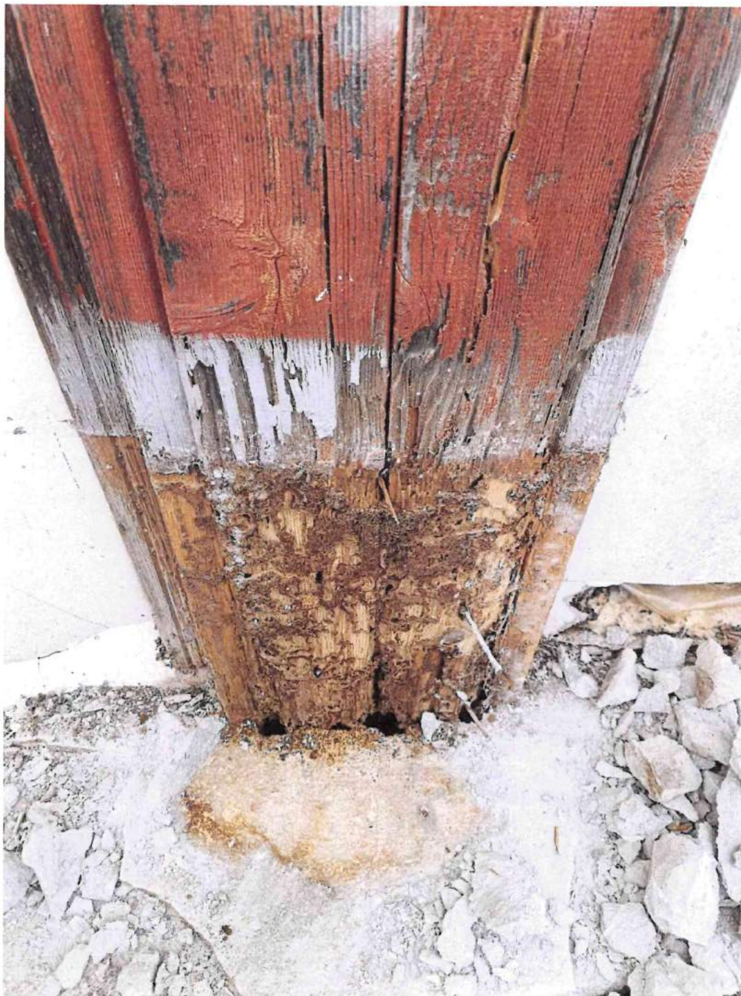
Dai fori è stata effettuata la video-ispezione.
