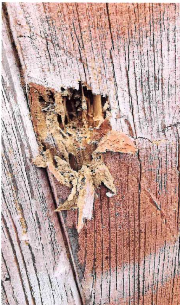
PARTICOLARI DI DEGRADO NELLA PARTE INFERIORE DI ALCUNI PILASTRI
