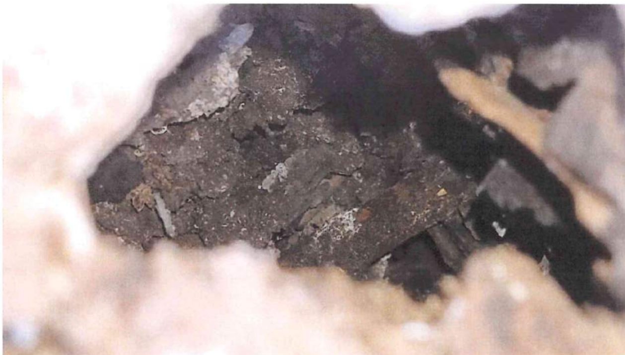
Dimostrata l'assenza della base del pilastro.
