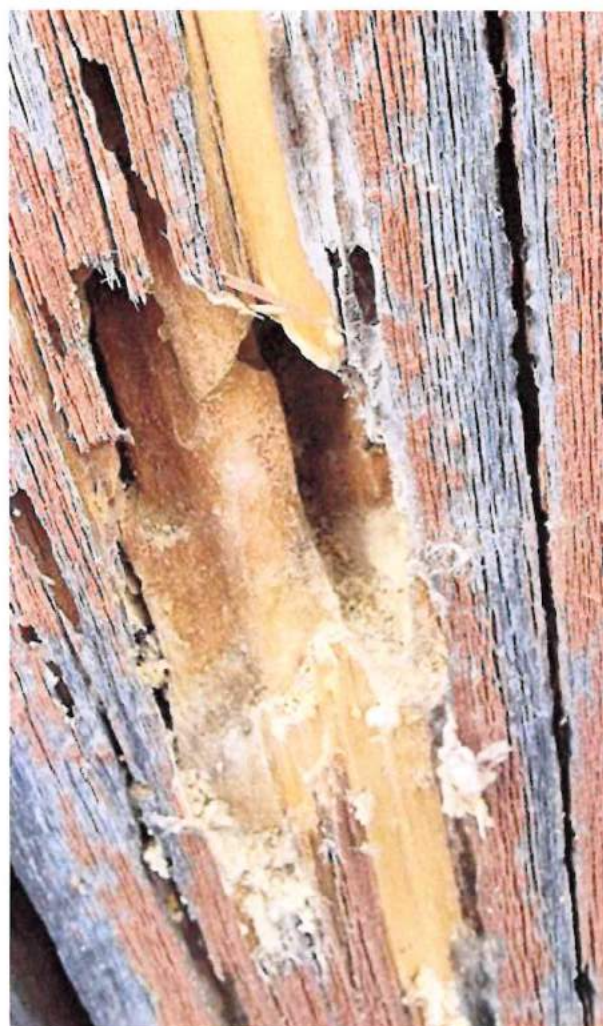
PARTICOLARI DI DEGRADO NELLA PARTE INFERIORE DI ALCUNI PILASTRI
